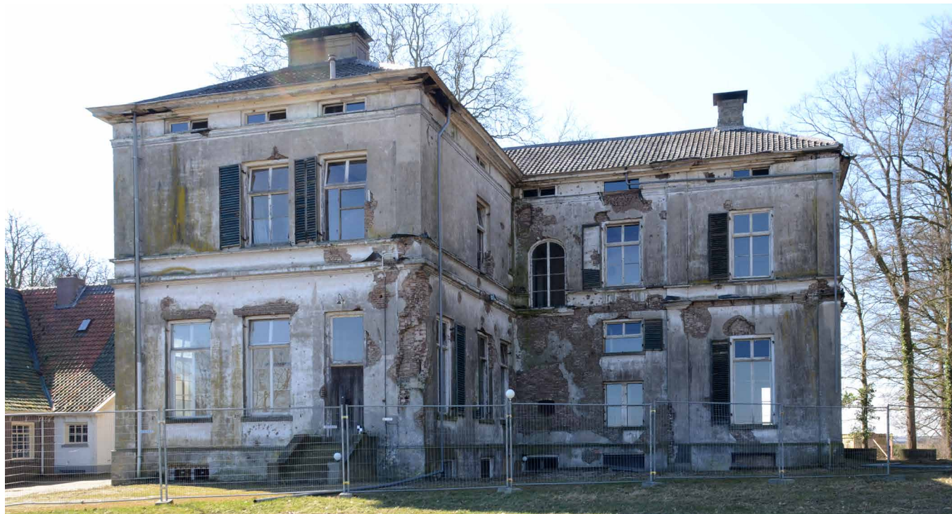
AFB. 7.8 Achtergevel Reuversweerd 'voor' de restauratie (Wido Quist).
