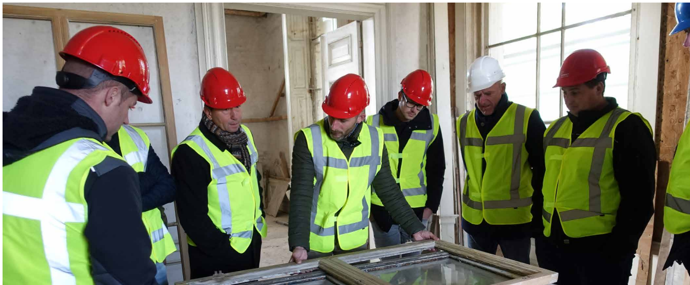
AFB. 5.12 In de tweede mobiele erfgoedwerkplaats op Reuversweerd werden diverse cursussen verzorgd door het GRC. Op het werk konden de lessen uit de theorie in de praktijk worden toegelicht (Hielkje Zijlstra).
