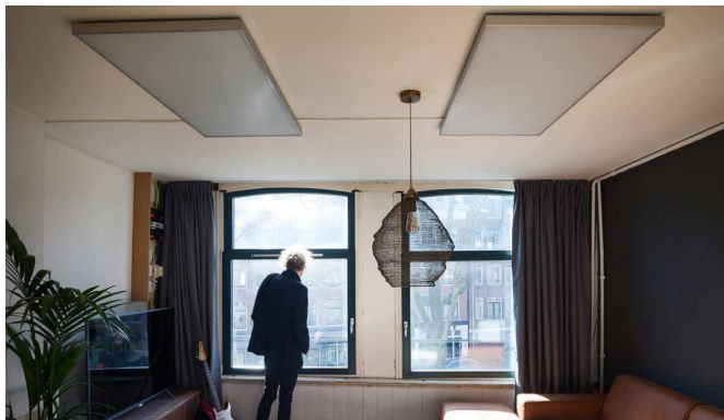
AFB. 8.10 Infraroodpanelen in een grachtenpand (OneWorld).
