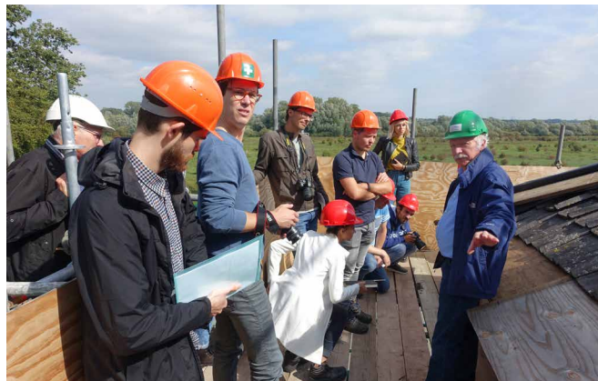
AFB. 2.4 Een ontmoeting tussen studenten en de projectmanager Jos van de Zande op steiger van Reuversweerd (Hielkje Zijlstra).
