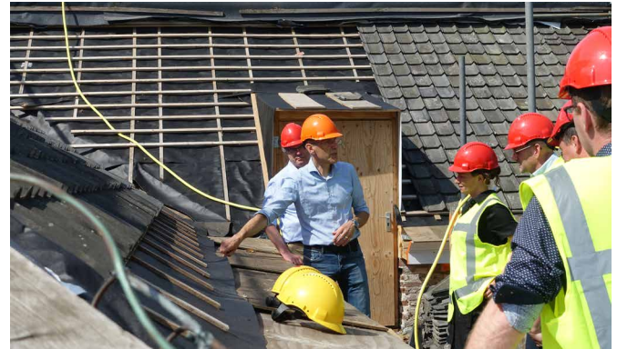
AFB. 7.3 Tijdens een cursus van de GRC op 18 juni 2019 vertelt projectleider Ron Spaan op de steiger aan de deelnemers hoe de isolatie van het dak is uitgevoerd op Reuversweerd (Hielkje Zijlstra).
