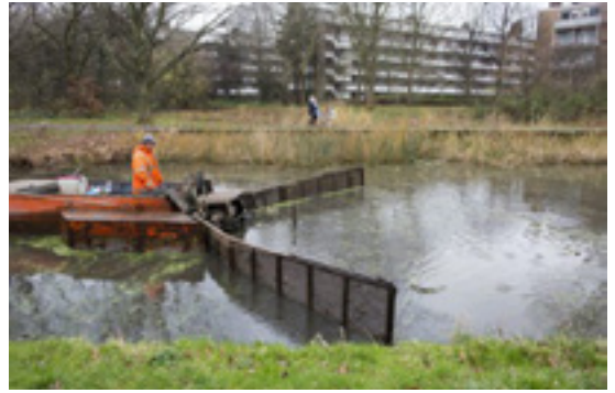
Dredging (photo: Unie van Waterschappen)
