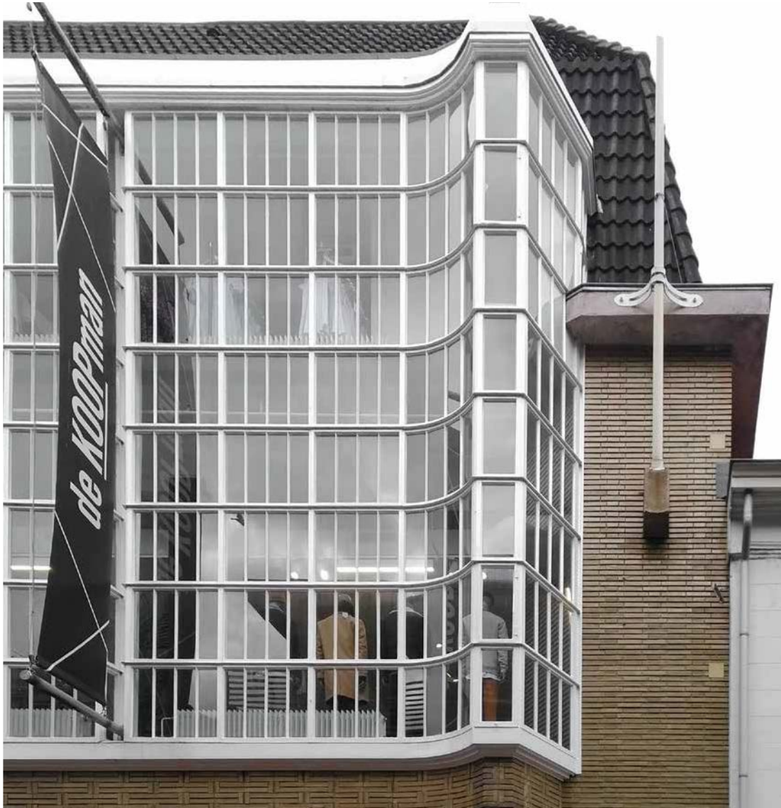
6. FRAGMENT PHOTOGRAPH OF THE UTRECHTSESTRAAT FACADE
