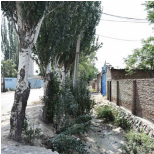
FIG. 4.61 Dry Ditch on Site 场地中干涸的水沟
