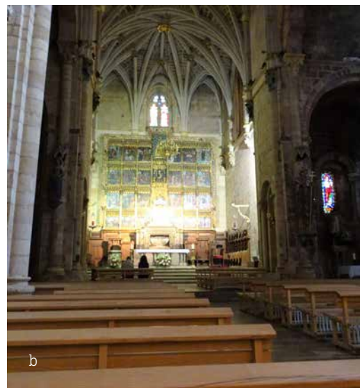
b) Innovative heating. San Isidoro, León.
