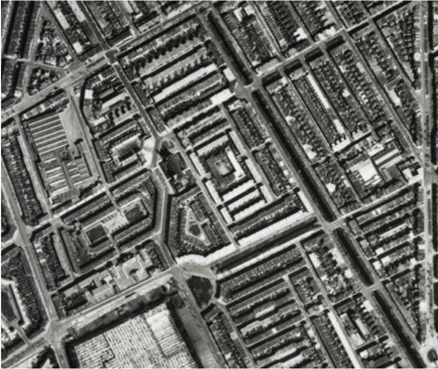
FIG. 1 Luchtfoto van de Heesterbuurt uit 1962, die onder meer de curieuze structuur van dubbele bouwblokken laat zien. Diagonaal rechts de begrenzing van de Heesterbuurt door de Valkenboskade [Gemeentearchief Den Haag]
