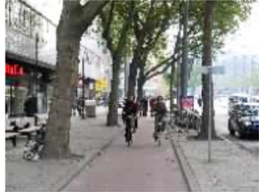
Fig. 236a en b LINKS Coolsingel boulevard te Rotterdam \geq 50 km/u, multifunctioneel profiel met krappe onbelijnde rijstroken en bufferruimte ter weerszijden van de trambaan, waar men tijdens een spontane winkeloversteek kan wachten op een oversteekbaar moment:
