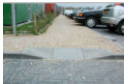
Fig. 405 t/m 407 LINKS Een probaat middel tegen auto's op de stoep is de dubbele trottoirband. Echter, zonder goede doordetailering wordt het ongewild een barrière voor gehandicapten, als er een hoogteverschil boven de 2 cm resteert. MIDDEN De trend de oudere bevolking mobiliteit te garanderen vraagt op alle ontwerp schalen aandacht voor de verplaatsingskenmerken. Eén slordigheid op het constructie ontwerpniveau R = 0,3 \text{ m} kan een heel bejaarden routeplan op R = 300 \text{ m} (wijkniveau) onbruikbaar maken. RECHTS Nabij trappen en treden in openbare routes moeten altijd een hellingbaan worden aangelegd. Bij semi-openbare routes volstaat desnoeds een 'kinderwagen-helling' in een trap.
