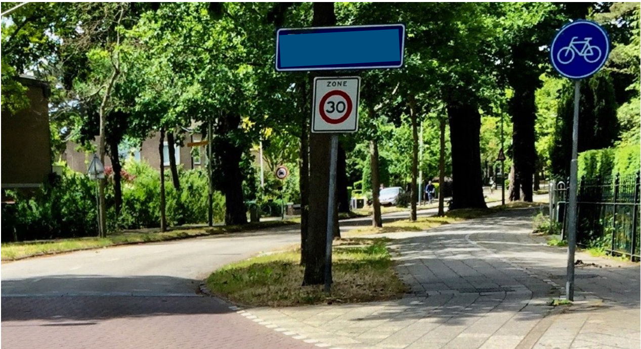
Fig. 164 a Te nonchalant plaatsen gemeenten ZONE30 borden bij een toegangsdrempel in de aanname dat - samen met enkele achterliggende drempels - het lopen, spelen, ontmoeten, de verkeersleefbaarheid, kortom de kwaliteit van wonen en verblijven met zo'n gebrekkige inrichting voldoende wordt geborgd.
