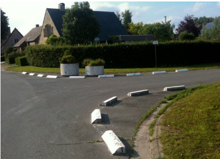
Fig. 144 In 2011 verkende men te Deinze (B) in de praktijk hoeveel de rijloper ten gunste van van overgangsruijme en rijnsnelheidsreductie kan worden getailleerd. De meerwaarde is het vergroten van de oplettendheid van bestuurders.
