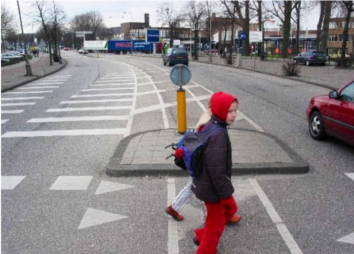
Fig. 165 Een ontwerp kenmerk van GOW's is doorstroming met constante relatief hoge snelheid: een 'laminare' verkeersstroom. Dat vereist verminderen van activiteiten die de stroom 'turbulent' maken, dus beperken van activiteiten langs de weg en voorkomen dat men de weg wil kruisen of op- en af wil af-wil rijden. Om de andere weggebruikers tegemoet te komen, maakte de voormalige Amsterdamse Deelgemeente Westerpark Amsterdam zo breed mogelijk.
