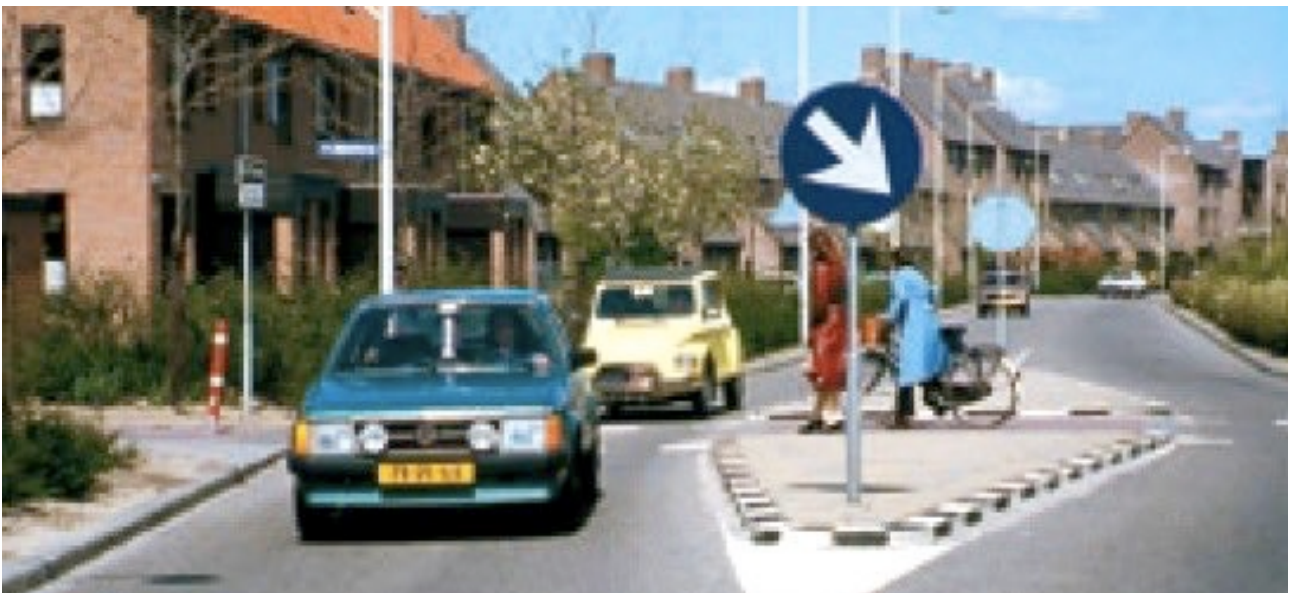
Fig. 104 Breed middeneiland in de wijkweg maakt het mogelijk dat gebruikers van de hoofdfietsroute de wijkweg in twee fasen oversteken. Het verhoogt de capaciteit op de wijkweg, verkort de oversteeftijd langzaam verkeer en voorkomt dat langzaam verkeer risico's neemt.
