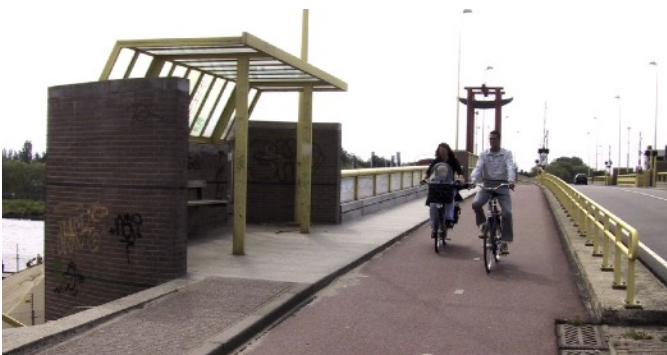
Fig. 468 Luifel tegen verkleumen verkort gevoelsmatig de wachttijd van fietsers bij open brug in het Noord-Hollands Kanaal.
