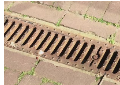
Fig. 79 a en b De winkelstraat te Bloemendaal heeft 'van deur-tot-deur verharding'. Het hemelwater wordt afgevoerd van de winkels naar molgoten 3 à 5 m van de gevels. Er is één-richtingverkeer voor de auto met tegengesteld fietsen.
