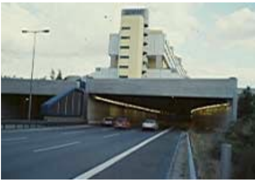
Fig. 28 a en b LINKS West-Berlijn creëerde reeds medio jaren tachtig extra bouwvolume door parkeerdekken boven de westelijk ringweg met daarboven terraswoningen en flats te bouwen; overbouwung van een snelweg in de lengterichting geeft maximale ruimtewinst, extra kansen om wijken ter weerszijden te verbinden en isoleert de verkeersshinder, maar is relatief duur door maatregelen tegen explosie- en brandgevaar.
