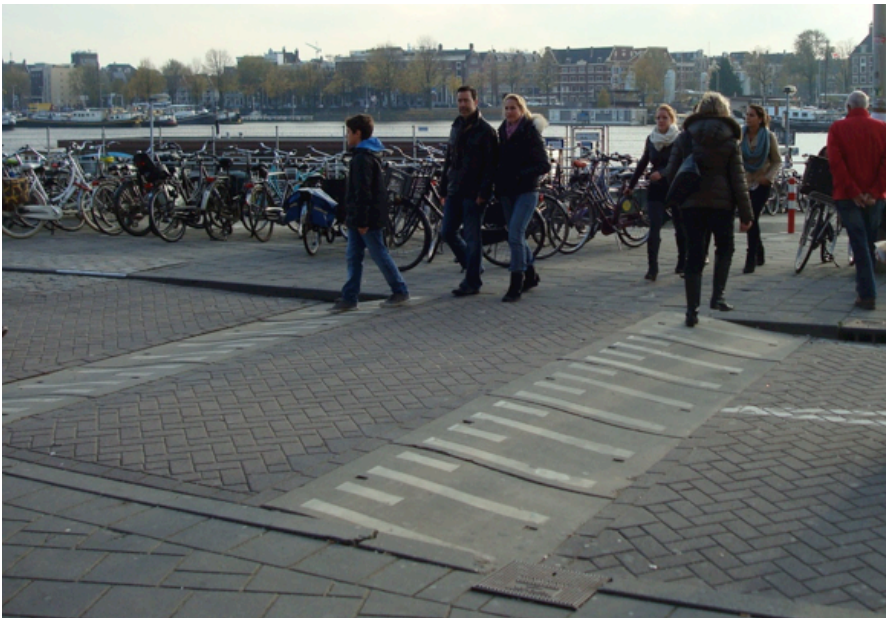
Fig. 158 f Voorbeeld van een oversteekdrempel met vlakke bovenzijde tegenover de Bibliotheek bij het Oosterdok in Amsterdam. Duidelijk herkenbaar voor het rijverkeer en gemakkelijk voor overstekende voetgangers met een wandelwagen, boodschappenkar, rollator of rolstoel.
