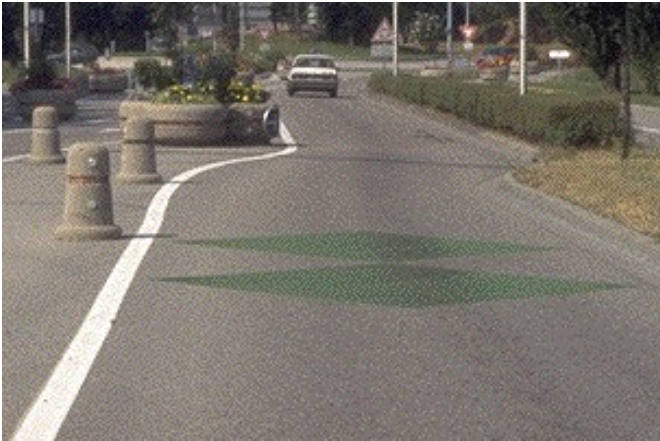
Fig. 518 b Reduceren van rijnsnelheid en opvoeren oplettendheid vlak voor een rotonde door èn tailleren èn echelonneren van de gescheiden rijbanen te Grenoble
