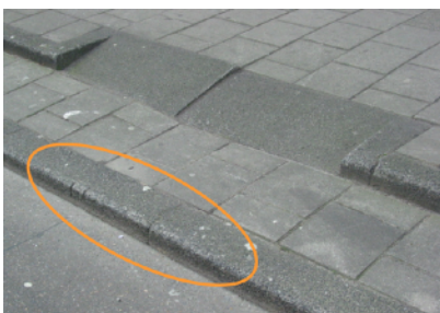
Fig. 405 t/m 407 LINKS Een probaat middel tegen auto's op de stoep is de dubbele trottoirband. Echter, zonder goede doordetailering wordt het ongewild een barrière voor gehandicapten, als er een hoogteverschil boven de 2 cm resteert. MIDDEN De trend de oudere bevolking mobiliteit te garanderen vraagt op alle ontwerp schalen aandacht voor de verplaatsingskenmerken. Eén slordigheid op het constructie ontwerpniveau R = 0,3 \text{ m} kan een heel bejaarden routeplan op R = 300 \text{ m} (wijkniveau) onbruikbaar maken. RECHTS Nabij trappen en treden in openbare routes moeten altijd een hellingbaan worden aangelegd. Bij semi-openbare routes volstaat desnoeds een 'kinderwagen-helling' in een trap.
