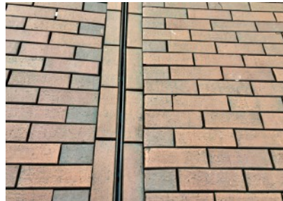
Fig. 79 a en b De winkelstraat te Bloemendaal heeft 'van deur-tot-deur verharding'. Het hemelwater wordt afgevoerd van de winkels naar molgoten 3 à 5 m van de gevels. Er is één-richtingverkeer voor de auto met tegengesteld fietsen.
