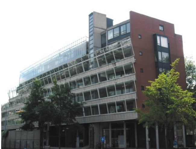
Fig. 595 en 596 LINKS Nabij station Amsterdam CS konden nabij het station ineen stedelijk straatprofiel flats worden gerealiseerd door ze vanaf de spoorzijde te ontsluiten via een geheel (geluids)dichte galerij. RECHTS In Maastricht werd het stedelijke profiel behouden door de nieuwbouw te voorzien van een geluidwerende glazen vide.
