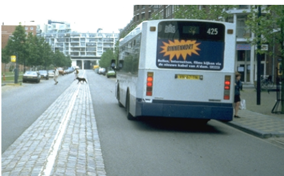
Fig. 483 t/m 485 LINKS Drempels en 30 km/u inritten hinderen fietsen. Kostenbesparing door handhaving straatbanden en behoud asfalt. Zo ontstond in 1980 Bloemendaenl haar eerste fietsvriendelijk Low-Cost 30 km entree. (Zie details en maatvoering Fig. 139 & 154).
