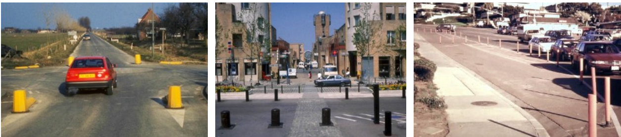
Fig. 519 t/m 521 LINKS Bescherming van afslaande fietsen te Culemborg. MIDDE N Straatmeubilair stelt ruimte veilig om te flaneren of snel over te steken op weg naar het regionale (RER) station Gergy Pontoise (F) RECHTS Proef in 1997 of of rijbaanversmalling (tailleren) om de uitloop van station Encinitas CA (USA) naar het P-terrein veiliger te maken.
