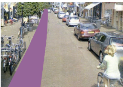
Fig. 79 a en b De winkelstraat te Bloemendaal heeft 'van deur-tot-deur verharding'. Het hemelwater wordt afgevoerd van de winkels naar molgoten 3 à 5 m van de gevels. Er is één-richtingverkeer voor de auto met tegengesteld fietsen.
