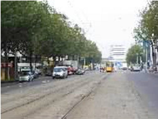
Fig. 236a en b LINKS Coolsingel boulevard te Rotterdam \geq 50 km/u, multifunctioneel profiel met krappe onbelijnde rijstroken en bufferruimte ter weerszijden van de trambaan, waar men tijdens een spontane winkeloversteek kan wachten op een oversteekbaar moment:
