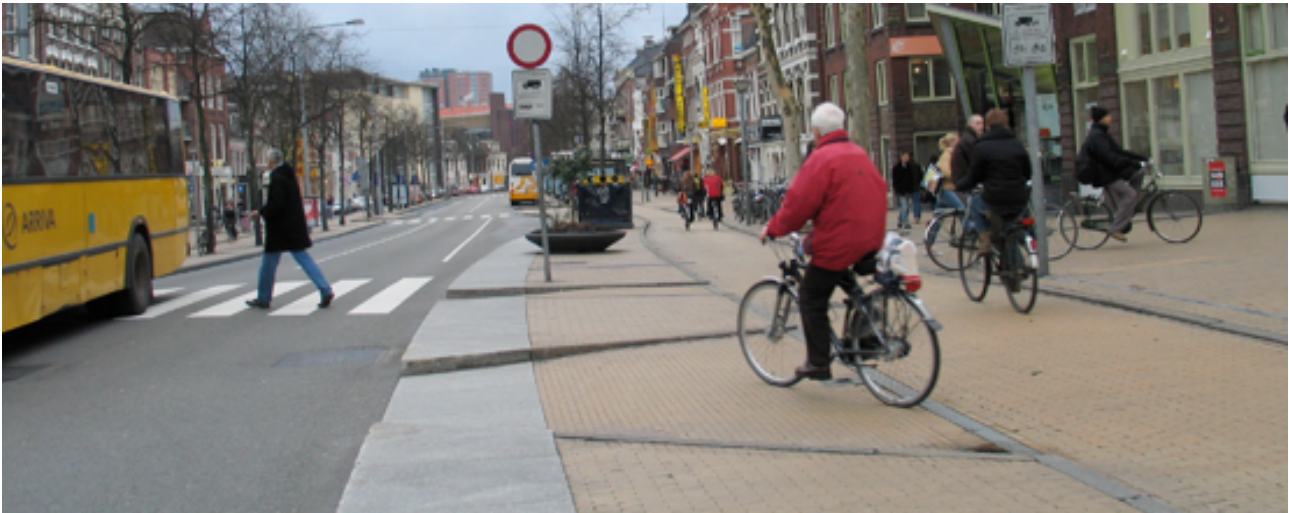
Fig. 227 De oude ringweg rondom het centrum van Groningen is omgebouwd van SW Stroomweg tot een soort stedelijke GOW. De ontsluitingsfunctie past nu beter verblijfsgebied oude centrum; OV en langzaam verkeer hebben een centrale positie binnen het profiel; verbodsborden beperken de toegang van auto. (Foto met dank aan M. De Jong)
