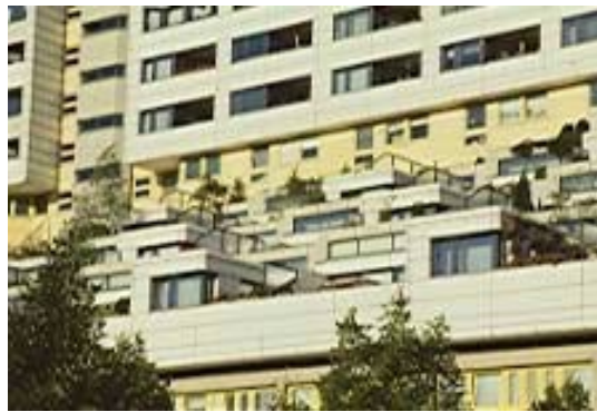
Fig. 28 a en b LINKS West-Berlijn creëerde reeds medio jaren tachtig extra bouwvolume door parkeerdekken boven de westelijk ringweg met daarboven terraswoningen en flats te bouwen; overbouwung van een snelweg in de lengterichting geeft maximale ruimtewinst, extra kansen om wijken ter weerszijden te verbinden en isoleert de verkeersshinder, maar is relatief duur door maatregelen tegen explosie- en brandgevaar.
