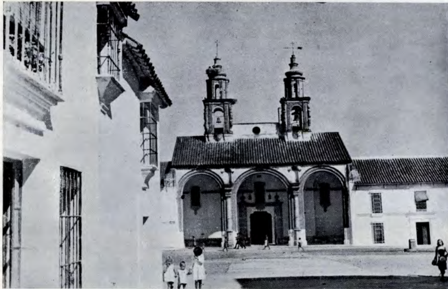
Aspecto exterior de la Iglesia de La Carlota.
