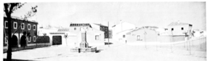
LA OBRA DE LA DIRECCIÓN GENERAL DE REGIONES DEVASTADAS Y REPARACIONES
