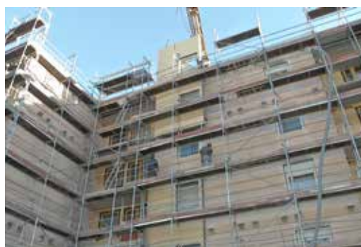
FIG. 7 SINFONIA project – panel installation (source: Benedikter Architekten)
