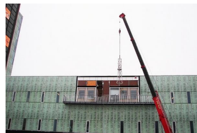
► Fig. 1: BPS Test Façade, TU/e.
