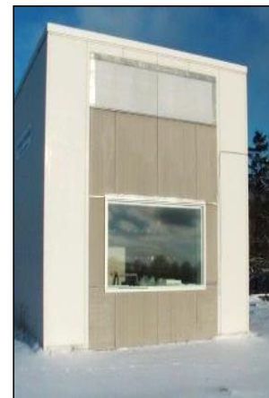
► Fig. 3: Façade test beds
