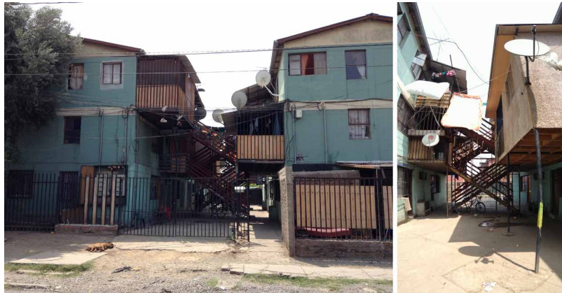
FIGURE 6.3 Condominium F3, Valle de la Luna before the intervention. Source: Proyecto Propio
