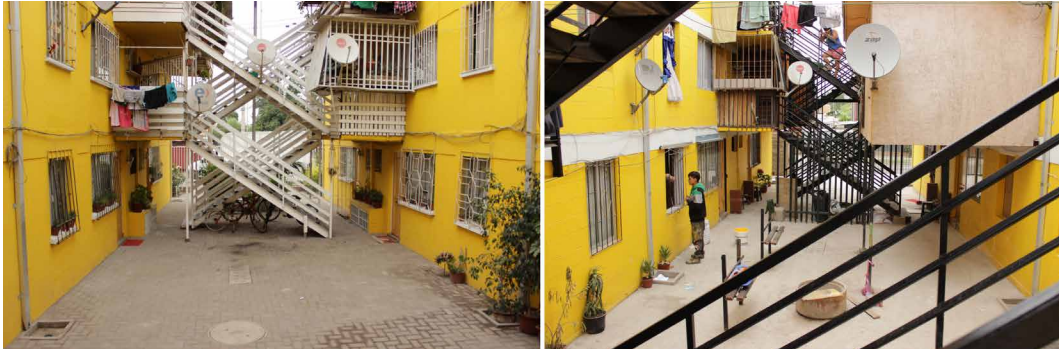
FIGURE 6.5 Condominium F3, Valle de la Luna after the intervention. Source: Proyecto Propio
