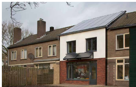
FIGUUR 2.20 Prototype Arnhem (bron: Energiesprong | Stroomversnelling | Frank Hanswijk | Dura Vermeer | Portaal)
