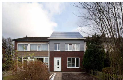
FIGUUR 2.23 Prototype Stadskanaal (bron: Energiesprong | Stroomversnelling | Ballast-Nedam | Lefier)
