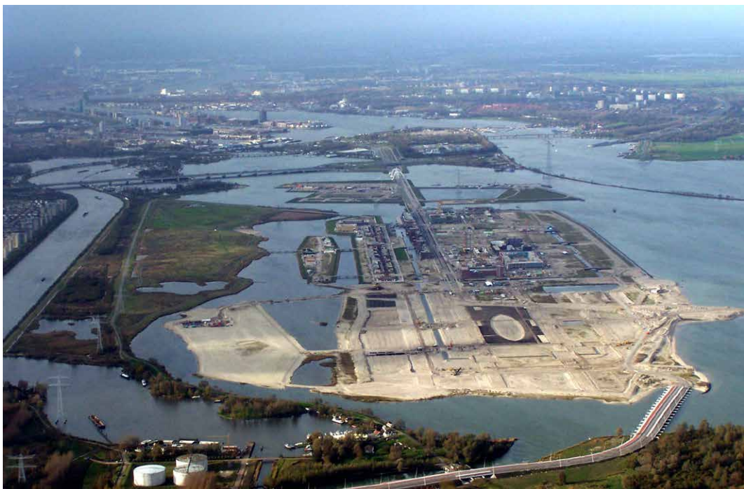
AFBEELDING 5.34 Steigereiland (boven) en Haveneiland-West (midden) tijdens de bouw november 2004 gezien vanuit het zuidoosten. Op het Haveneiland-Oost (onder) is het latere Theo van Goghpark al te zien en op de voorgrond ligt de Benno Premselabrug.
