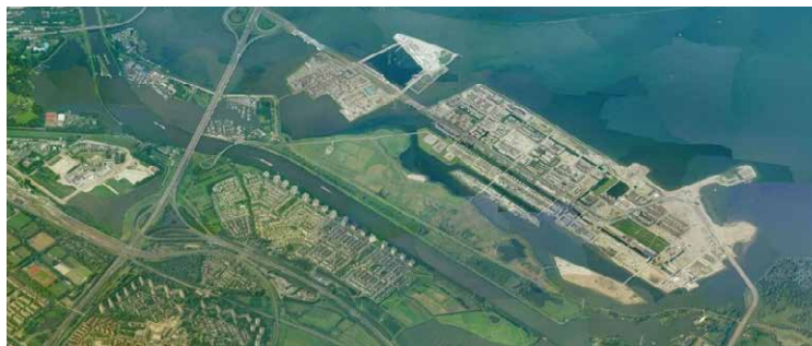
AFBEELDING 5.51 Het 'Diemerpark' volgens de NvU 1996 (boven) en uitgevoerd in 2013 (onder), gezien vanuit het zuiden.
