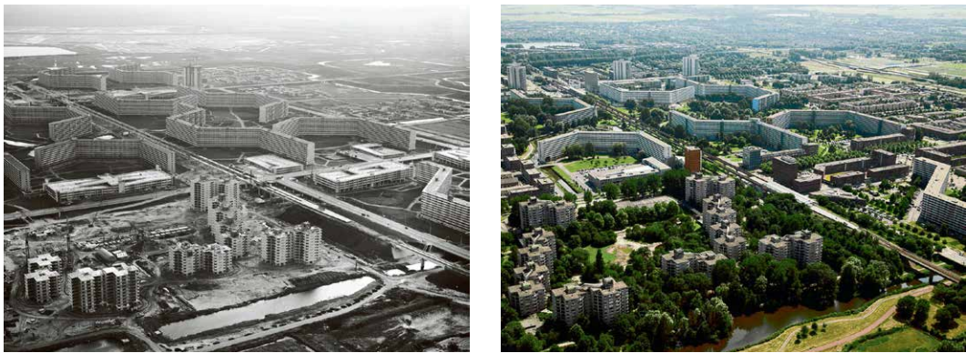
AFBEELDING 4.28 Kruising van 'stadsspoor' en 'secundaire weg' uitgevoerd als verhoogde Bijlmerdreef in 1974 (links) en verlaagd in 2013 (rechts), gezien vanuit het noorden, met op de voorgrond Groenhoven en Gouden Leeuw en metrostation Ganzenhoef (links in aanleg), daarachter deelplan E en D met verbindingsgroen , rechts Groesbeekdreef (rechts verlaagd en met woonbuurt Gulden Kruis of Kortvoort), en rechts op de achtergrond 'primaire weg' de verhoogde Gooiseweg en het Bijlmerpark (nu Nelson Mandelapark).
