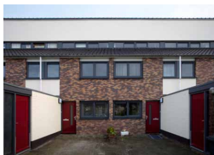
Renovatie Maarssenbroek (Bron: BAM)
