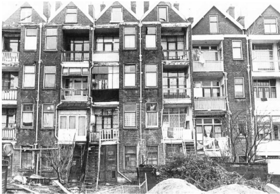
Figure 80 Het Oude Westen before renovation.
