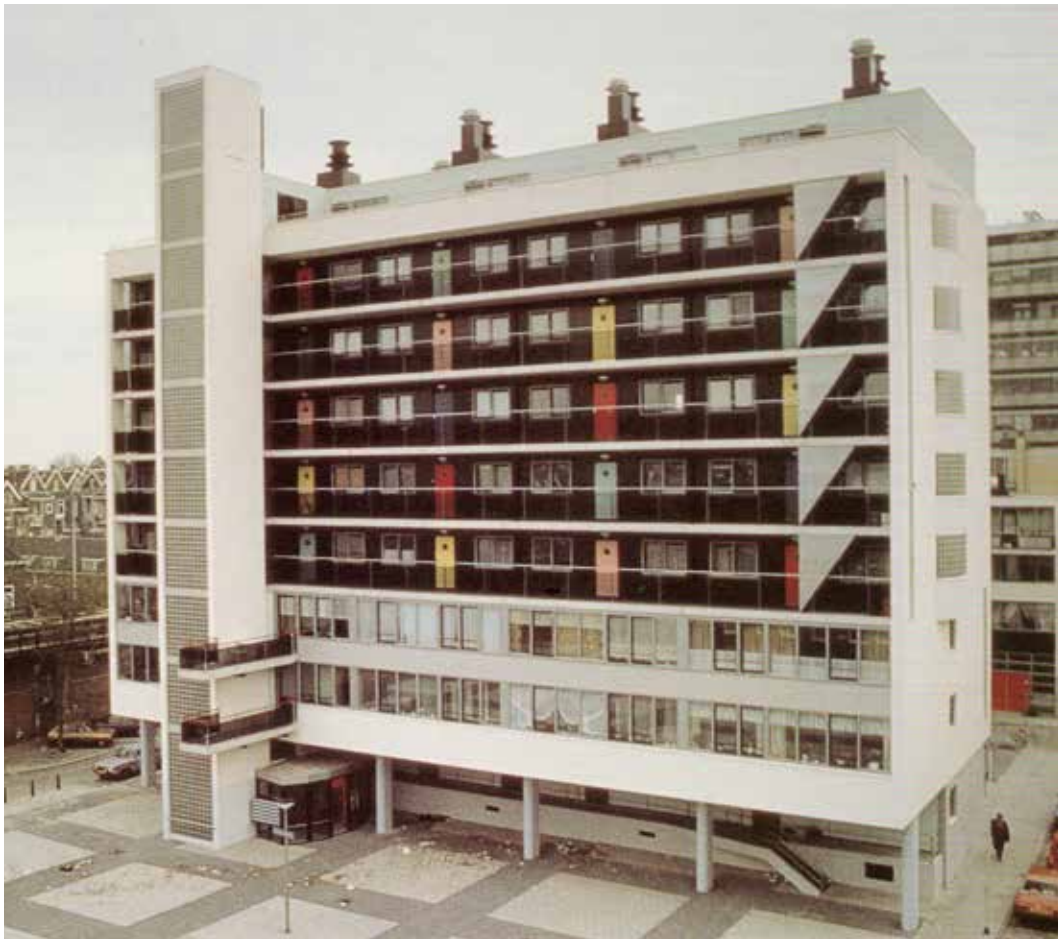
AFBEELDING 5.74 Woongebouw in de Agniesebuurt in Rotterdam, 1984-88, DKV Architecten; De foto laat de gevel van het negen lagen hoge gebouw aan het plein zien. De beganegrondwoningen worden vanaf een plint via een galerij ontsloten. Daarvoor bevindt zich een arcade. Hierdoor is een overgang van publiek naar privé gemaakt. De laagbouw in de wijk is achter dit gebouw nog net in beeld.
