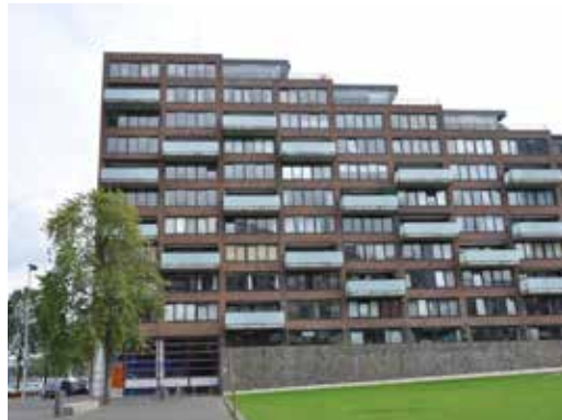
AFBEELDING 8.320 De gevel van Blok 2B naar Loods 24.
