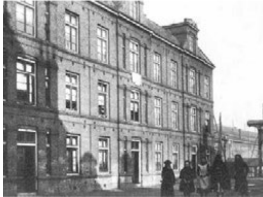
AFBEELDING 5.13 Woningbouw in Amsterdam, Oostenburgermiddenstraat 85-89, 1852-53, architect H. Hana. In de gevel naar de straat toe valt de strakke gevellijn op en de afwezigheid van de oude vertrouwde stoep. Het lijkt of de straat al voorzien is van een trottoir. Architectonische middelen accentueren per woongebouw de gemeenschappelijke entree. Het zijn uitstekend metselwerk, smalle verticale raampjes aan weerszijden van de ingang, een dakkapel boven de entree en het gedraaide dak.
