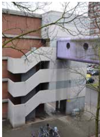
AFBEELDING 8.210 Trap, lifttoren en brug. Foto: auteur.
