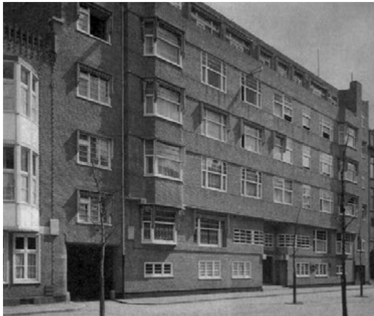
AFBEELDING 5.36 Huis Oldenhoeck in Amsterdam, in 1925-26 gebouwd, architect Warners. Dit gebouw is een deel van een blokbebouwing. Twee naar voren springende erkers (op de foto is de linke erker in beeld) markeren de zijwaartse begrenzing van het gebouw vanaf de eerste verdieping. Links bevindt zich een doorgang naar een binnentuin waar een tennisbaan gesitueerd is. De bovenste verdieping springt – met uitzondering van de erkers – terug zodat er een balkon ontstaat, en tegelijkertijd een afsluiting. De entree ligt in het midden, horizontaal lopende vensterbanden lopen in een ronding naar de iets terugliggende zijwand van het open entreeportaal.
