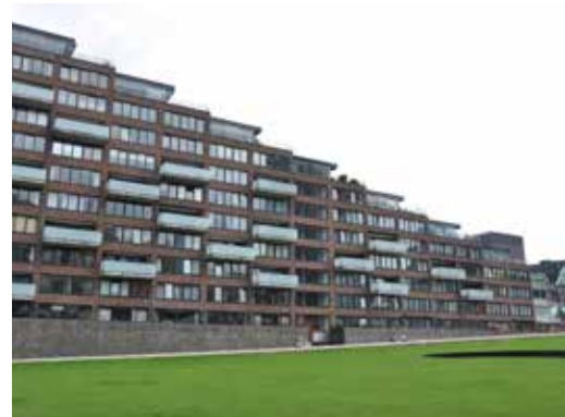
AFBEELDING 8.321 De gevel van Blok 2B naar Loods 24.
