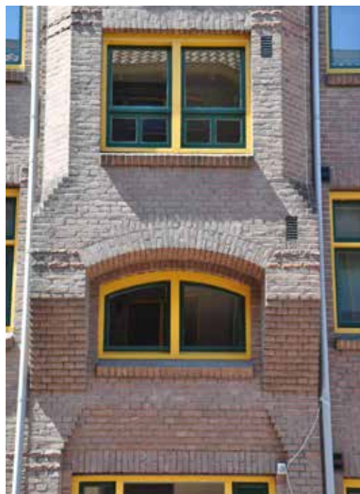
AFBEELDING 6.20 De detailfoto laat de zorgvuldig ingezette architectonische middelen van de erker en de baksteendetails zien.
