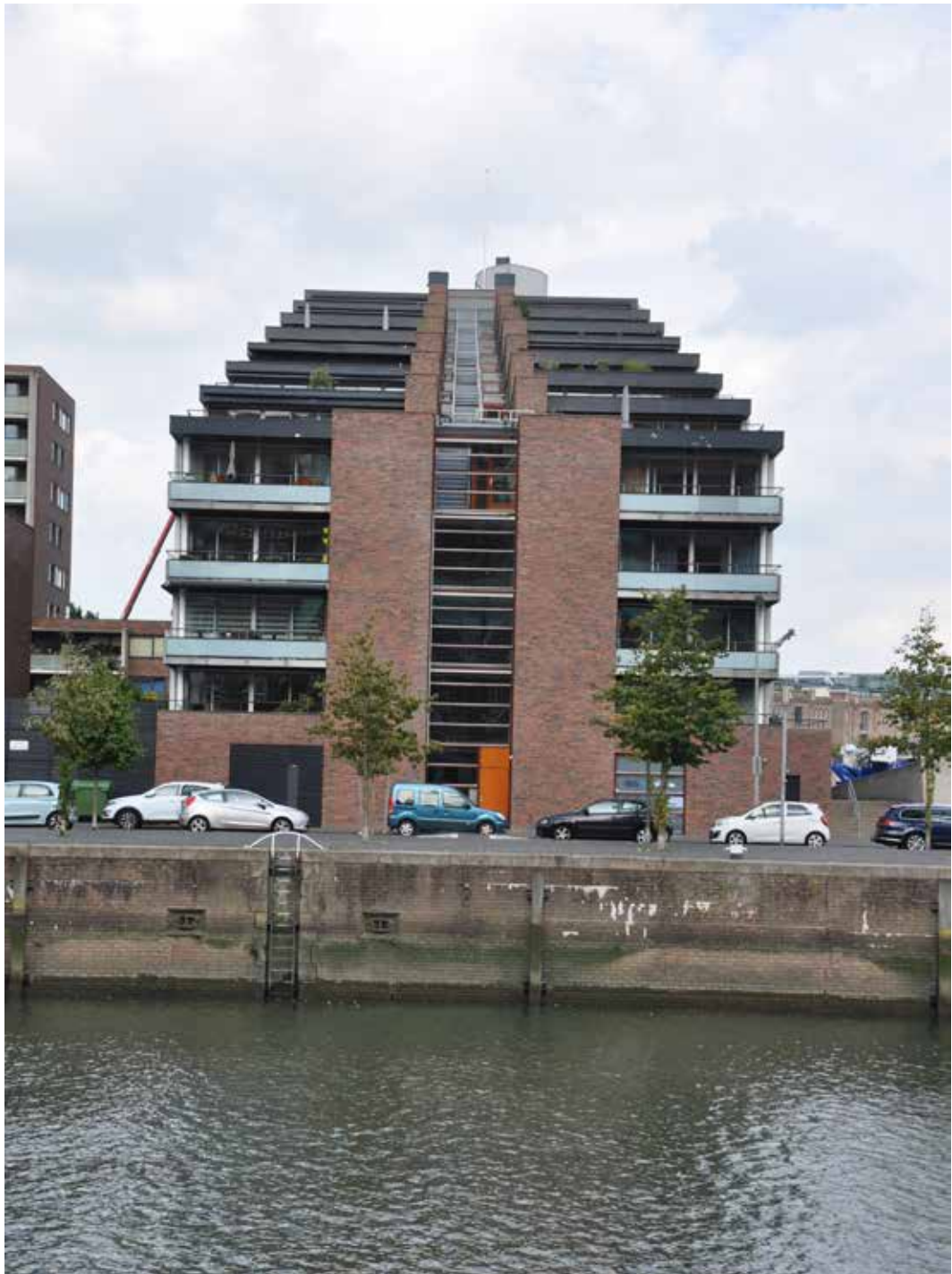
AFBEELDING 8.309 De kopgevel aan de Spoorweghaven.
