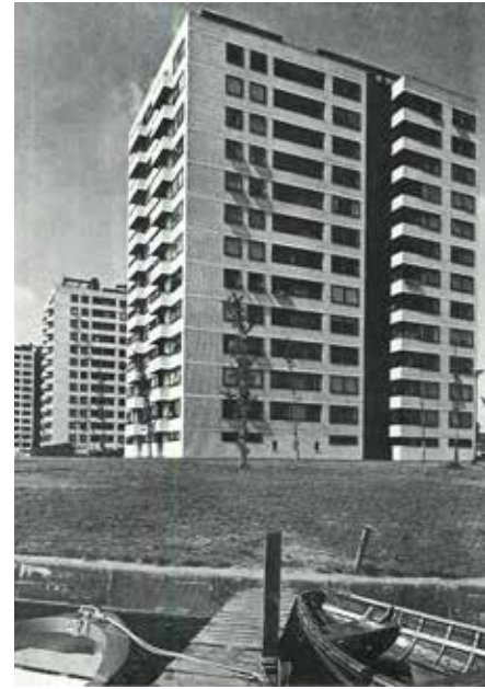
AFBEELDING 5.59 De Torenflats in Amsterdam, 1961-67, architecten Wieger Bruin (1893-1971) en bureau Vink en Van de Kuilen.
