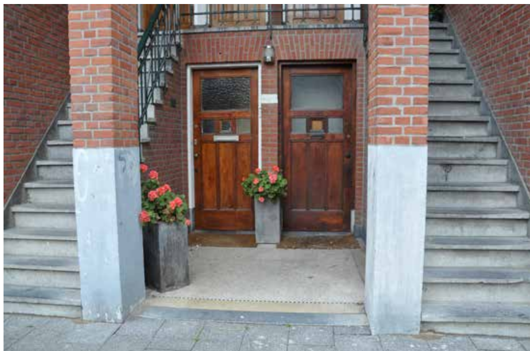
AFBEELDING 8.15 Op niveau van het trottoir markeert een materiaalwissel de overgang naar de entree's van de begane grondwoningen, eerst is een hardstenen band in de vloer te zien. Dan begint een terrazzo vloer die een bijzondere rand heeft.
