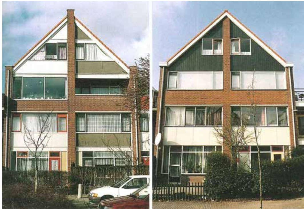
AFBEELDING 8.222 Voor en na de renovatie.
