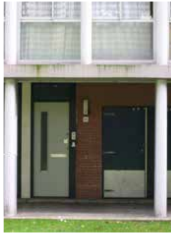
AFBEELDING 8.208 Entreedeur en bergingsdeur op de beganegrond.
