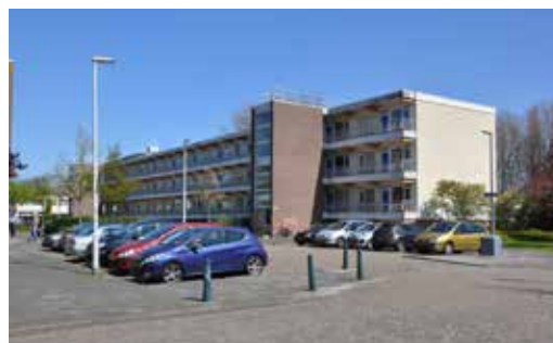
AFBEELDING 8.153 Foto hedendaagse situatie: alleen bij de trappenhuizen is het oorspronkelijke baksteen nog zichtbaar. Voor het gebouw ligt het pleintje dat nog steeds voor een groot deel voor voetgangers is.
