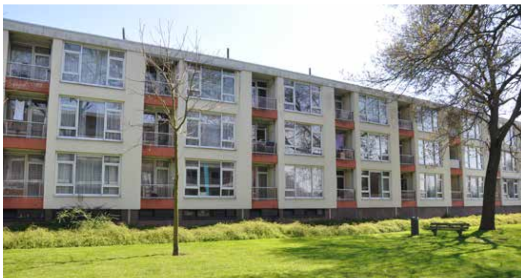
AFBEELDING 8.158 Vandaag de dag zijn de gevels gestuukt. De betonranden zijn niet meer te zien.
