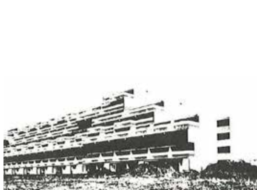
AFBEELDING 5.63 Woonheuvel Coevering-West in Geldrop, in 1975 opgeleverd door INBO-architecten. Als een experimenteel project werd subsidie aan dit project toegekend.
