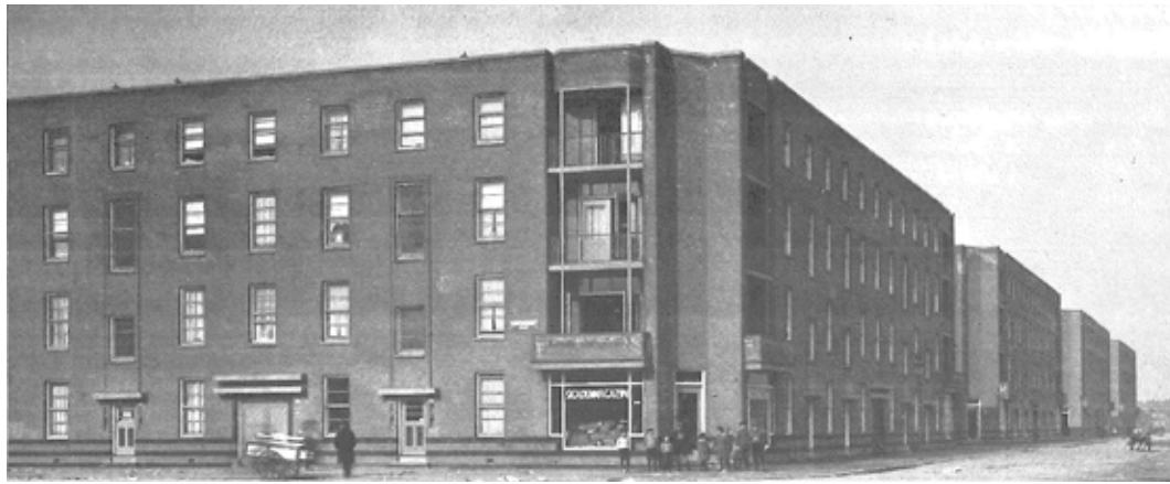
AFBEELDING 5.34 De woningen in Rotterdam Tussendijken in 1920 van J.J.P. Oud. Op de hoek is nu een winkel, de begane grondwoningen hebben geen eigen entree deur meer maar gebruiken het trappenhuis. Woonkamer en balkon zijn, behalve bij de hoekwoningen, naar het binnenhof gesitueerd. In de gevel naar de straat toe maakt Oud weer gebruik van accenten rond raampartijen om de gevel ritmisch te breken. De entrees zijn bij dit blok sterker gearculeerd, de poort naar de binnenhof is dubbelbreed en heeft twee betonnen lateien, de entree deuren naar het trappenhuis hebben een enkele latei. Hierdoor wordt het verschil tussen portiekentree en doorgang meteen zichtbaar.
