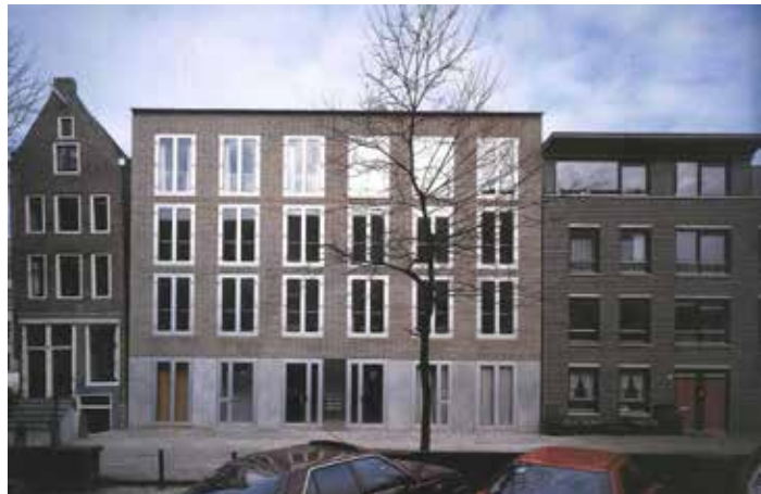
AFBEELDING 7.54 De gevel van Blok 4 in Amsterdam van Claus & Kaan architecten.
