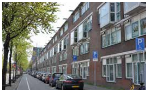
AFBEELDING 8.259 De gevel aan de noordzijde vandaag.
