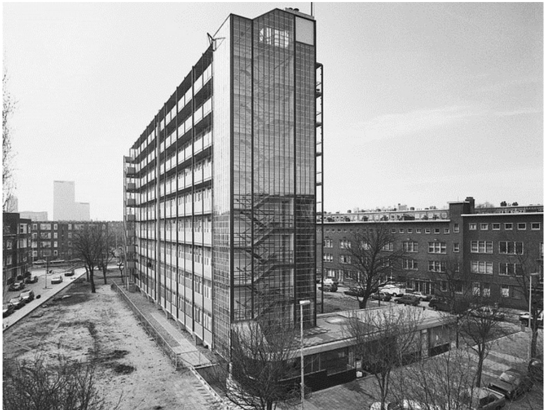
AFBEELDING 8.115 Galerijzijde en trappenhuis .
