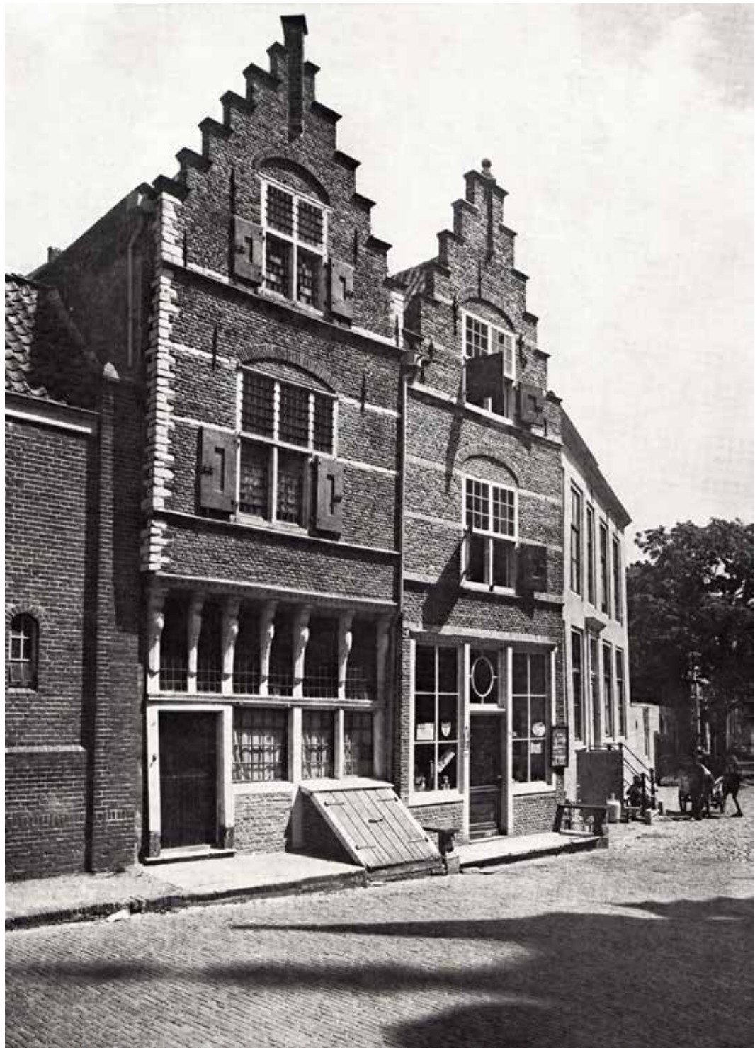
AFBEELDING 7.1 Twee gevels uit 1600 en 1625 Markt 2 en 4 in Veere. Het linkerpand heeft een bijzondere gevel omdat de entree deur aan de zijkant ligt. Het is niet helemaal duidelijk of dit met een zijkamer of gang te maken heeft; wel geeft de gevel een goede indruk van een situatie met zijgang. Het rechterpand heeft de entree deur in het midden.
