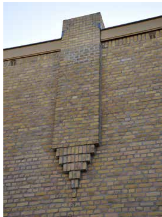
AFBEELDING 8.71 Detail in de gevel.
