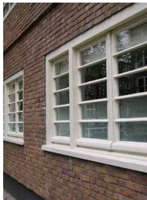
AFBEELDING 8.107 De openingen van de kelderimte.
