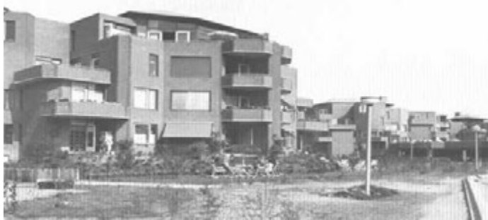
AFBEELDING 6.34 het Oostgaarde-project in Capelle a/d IJssel. De gevel reageert op de open verkaveling en de collectieve tuinen door zelf een overgangszone te worden, balkons zijn half of helemaal uitstekend, het gebouvolume springt terug om ruimte voor private dakterrassen te bieden en er ontstaan door de verdraaiing van de volumes nissen voor een beetje meer privacy ten opzichte van de collectieve tuin.
