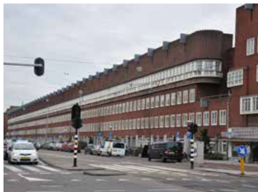
AFBEELDING 6.21 Woningen aan de Hoofdweg in Amsterdam, 1927 van architect Wijdeveld. De geleding van de gevel gebeurt door het uitkragen van penanten op de begane grond en toevoeging van hijsbalken aan de dakrand. De derde verdieping springt enkele centimeters naar voren. Hierdoor word een suggestie van een beschutte straat gewekt.
