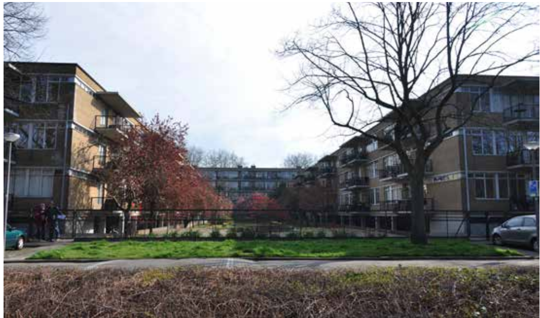
AFBEELDING 6.6 Woningbouw De Eendracht in Rotterdam Blijdorp, 1937, architect van den Broek en Bakema. Het blok is aan de westzijde geopend.
