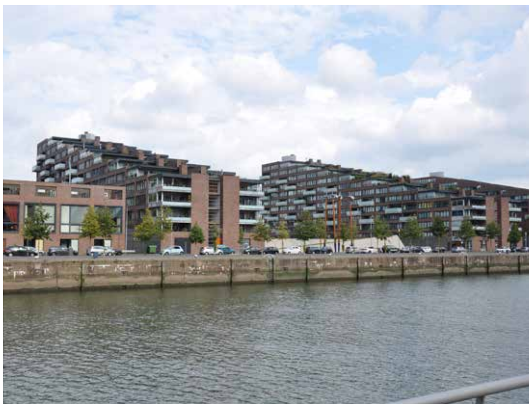
AFBEELDING 8.291 Plein Loods24 met de twee afgetrapte blokken, gezien vanaf de Spoorweghaven.
