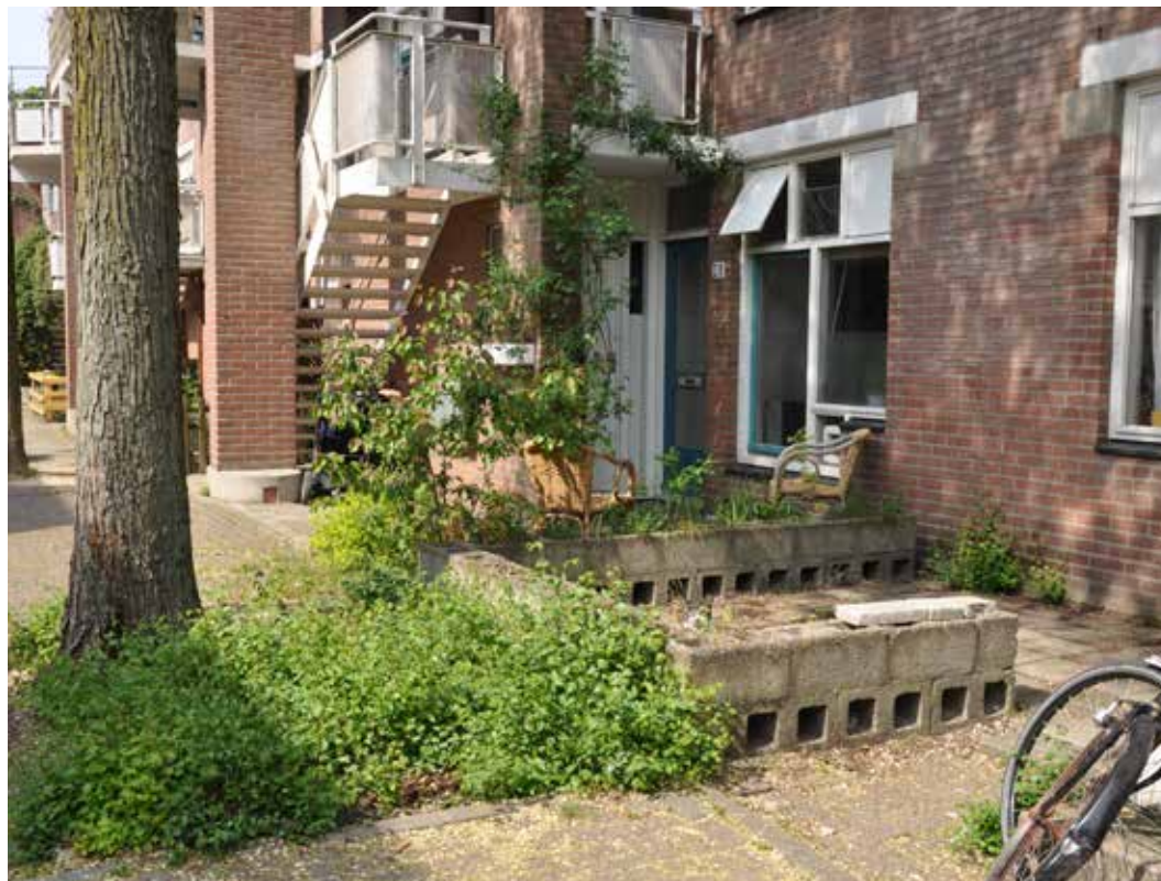
AFBEELDING 8.274 Betonlateien rusten op zichtbare consoles.
