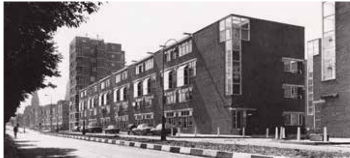
AFBEELDING 8.257 Oorspronkelijke situatie van de noordzijde en de woonstraat op zuid.
