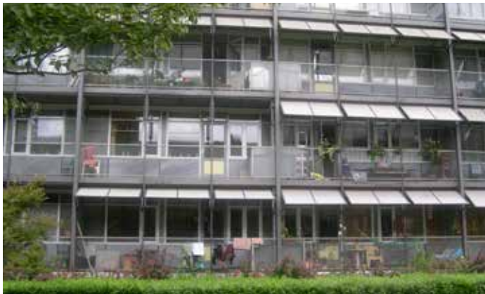
AFBEELDING 7.30 Zuidgevel met zonwering.
