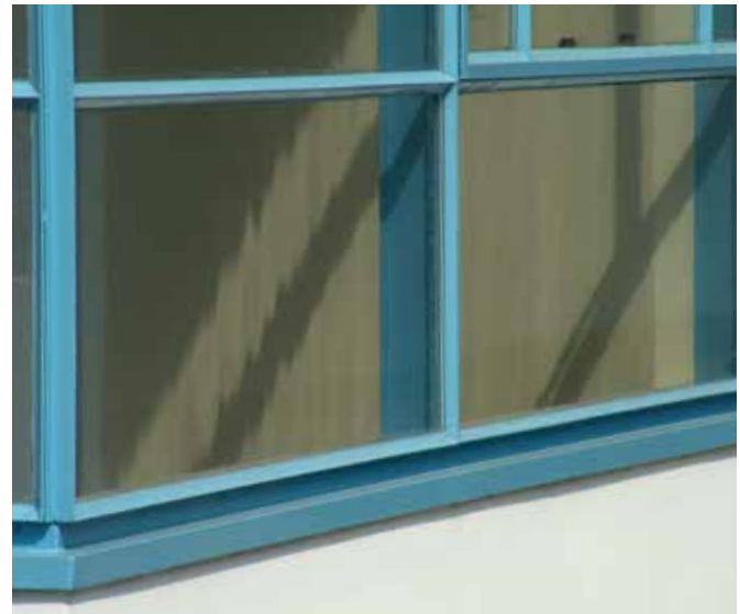
FIG. 5.34 Detail of the drawn single glass at one of the corners of the Main Building after restoration in 2003 / Taco Hermans, Rijksdienst voor het Cultureel Erfgoed
