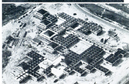
a. van eyck, burgerweeshuis in aanbouw | municipal orphanage under construction, amsterdam 1960
