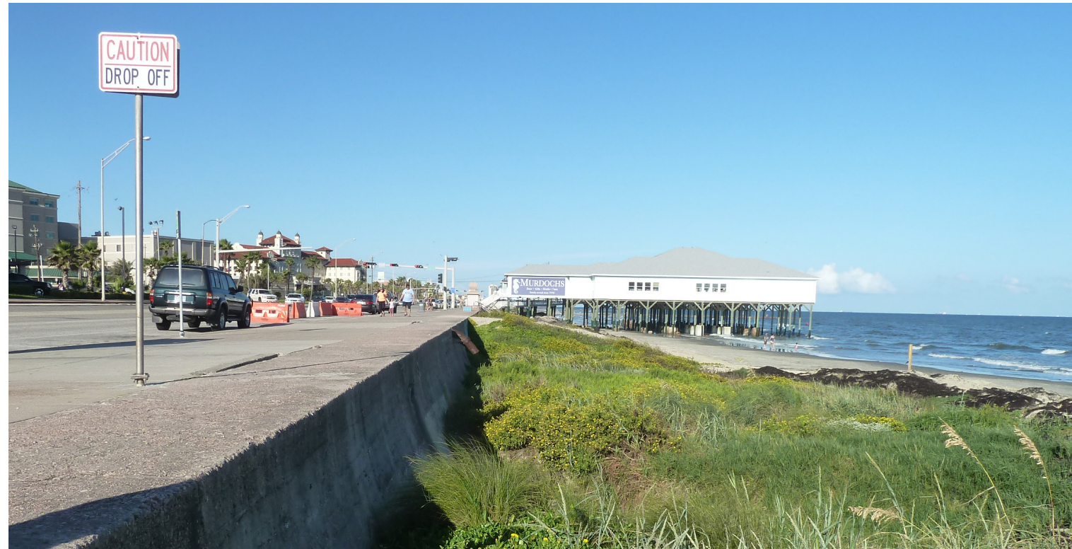
Figure 29. Galveston Seawall. (Photo Courtesy Baukje Kothuis)
