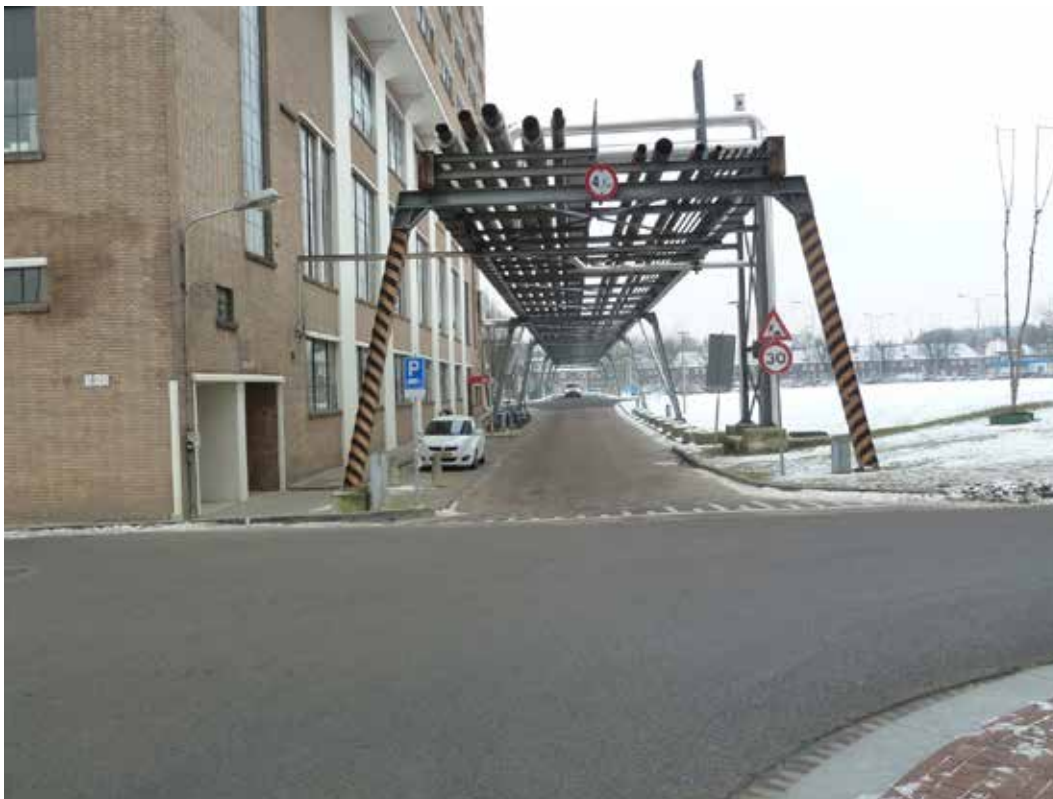
Figuur 39 Leidingstelsel ter plaatse van het Glasgebouw.
