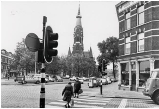
1972 Oranjeboomstraat with Wilhelminakerk church on the corner of Persoonsstraat before demolition
